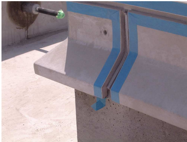
〈シーリング前〉
