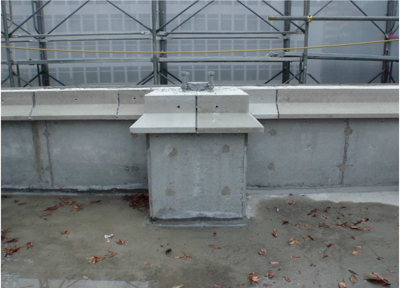
KRF-SO 出隅・入隅・クランク 加工品施工
